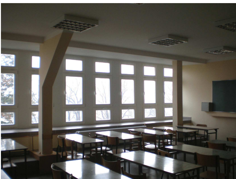
Fot. 6. Przy większości słupów usunięto miecze
